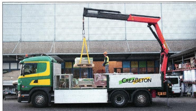
Kranarbeit: Die ersten Paletten werden in Alpnachstad bei einem Dachdecker abgeladen.
